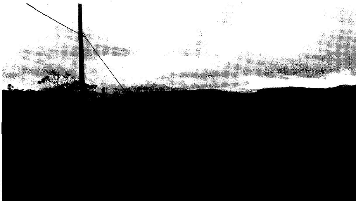
Figura 02 – Rede elétrica instalada na rua Geraldo Pacheco de Melo
